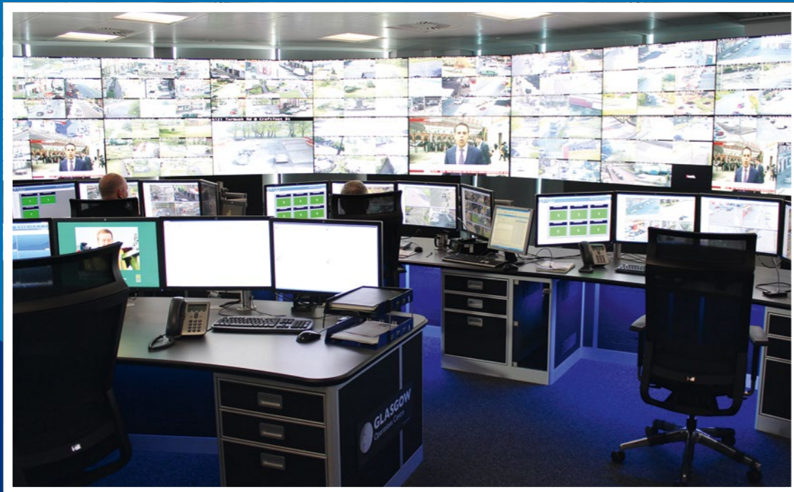
85 eyevis-Displays ermöglichen eine Übersicht über 440 Sicherheitskameras aus dem gesamten Stadtgebiet von Glasgow.
